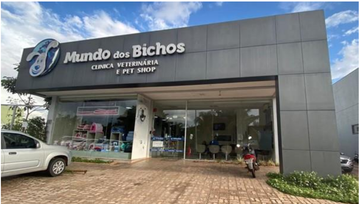
Figura 1. Fachada da Clínica Veterinária Mundo dos Bichos, Araguaína - TO.
