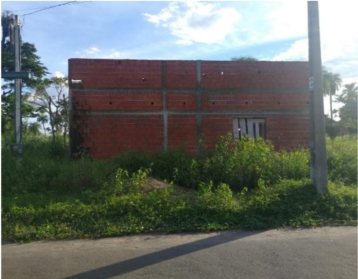
Figura 1. Sede própria ainda em construção
