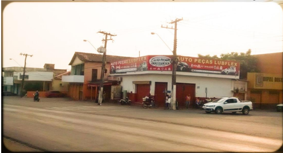
Fotografia 04: Estabelecimentos comerciais instalados à margem direita, no sentido Sul-Norte, da BR-153, esquina com a Avenida Cônego João Lima em Araguaína-TO.
