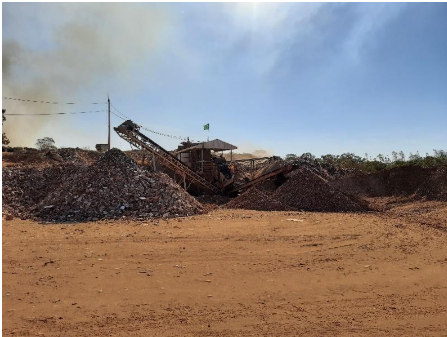
Figura 8 – Usina de Reciclagem de RCC - Processo de peneiramento e separação de granulometrias
