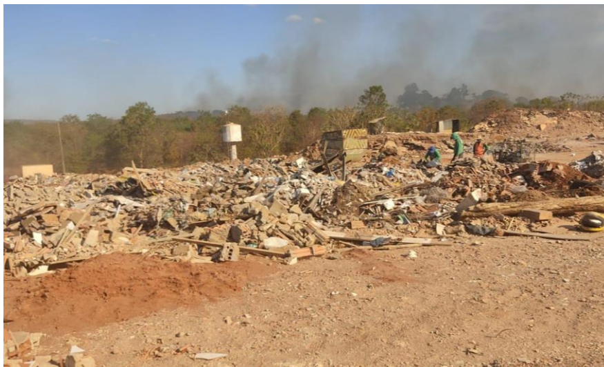
Figura 10 – Usina de Reciclagem de RCC - Praça de triagem dos resíduos, em sua maioria concretos e cerâmicas.
