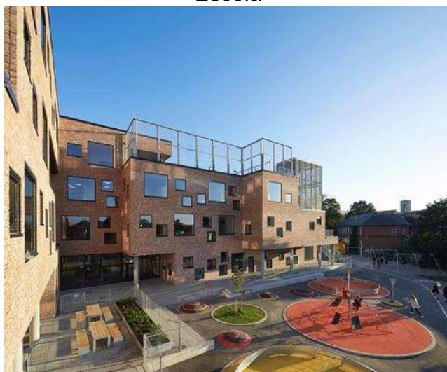
Figura 36 - Fachada de Tijolos Reaproveitados da Escola
