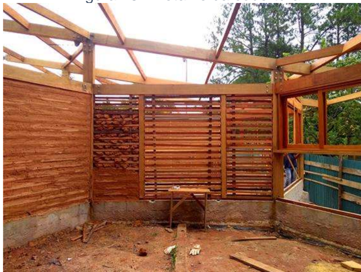
Figura 28 - Detalhe da cobertura
