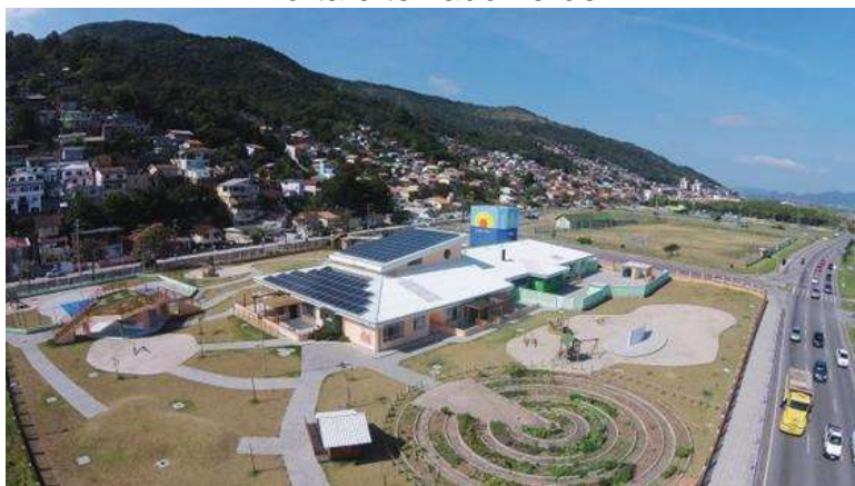
Figura 19 - Creche Hassis, vista das placas solares, horta e telhado verde.
