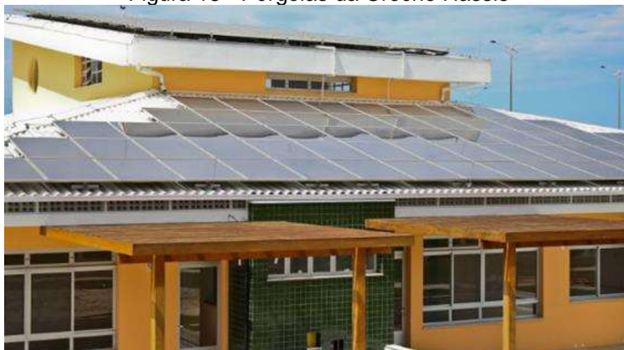
Figura 18 - Pérgolas da Creche Hassis
