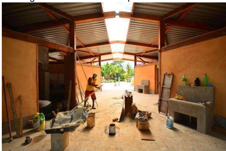
Figura 27 - Parede de taipa sendo realizada
