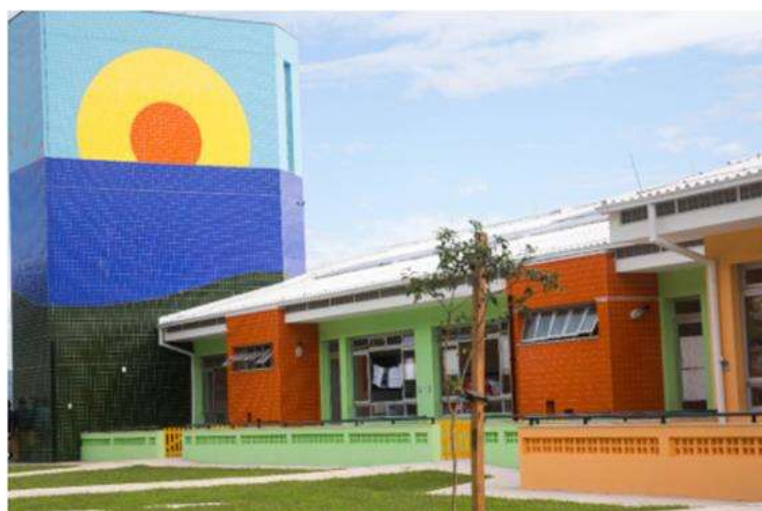
Figura 17 - Fachada da Creche Hassis
