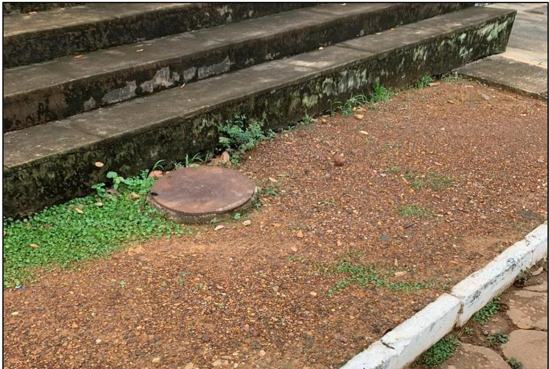
**Figura 9** - Fossa rudimentar em operação nas áreas com rede coletora implantada
