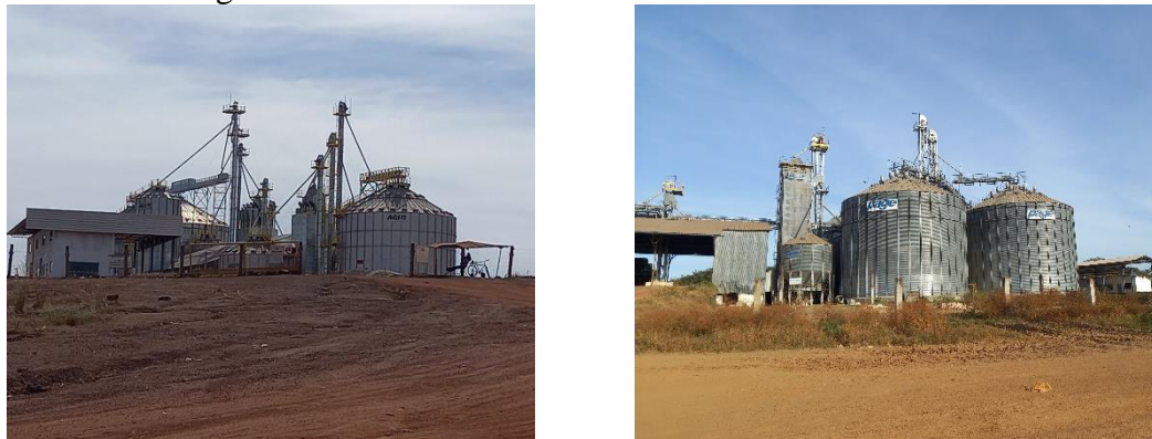
Figura 5 Armazéns e Silos instalados na AEG-01
