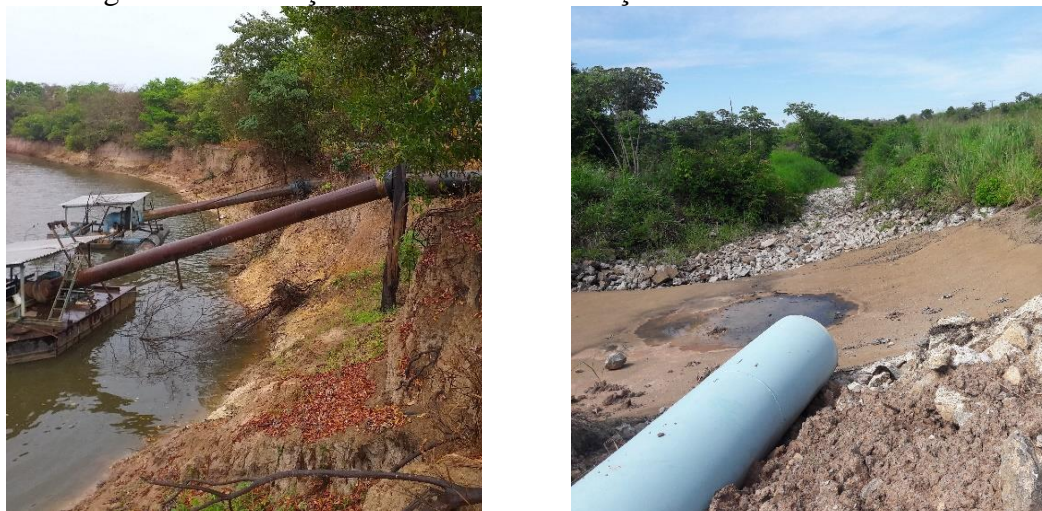
Figura 30- Instalações de bombas e tubulações no Rio Formoso
