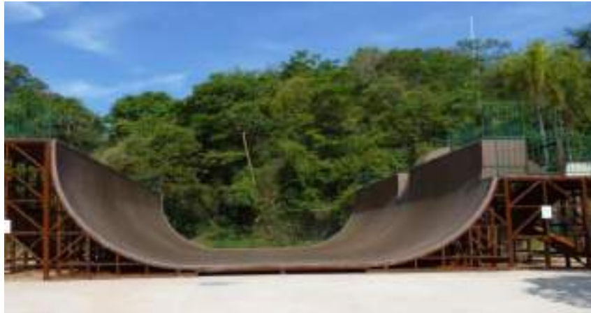
Figura 37: Pista vertical em Parque das Mangabeiras (Belo Horizonte/MG).
