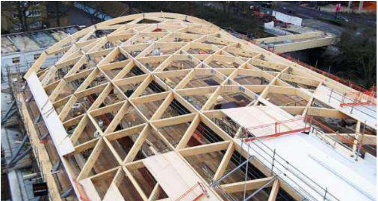
Figura 23. Estrutura Diagrid durante a construção. Fotografia: WWF-UK
