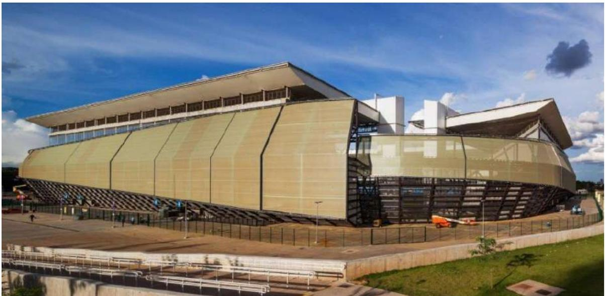
Figura 60. Membrana microclimática têxtil usado na Arena Pantanal em Cuiabá - MT. Fotografia: Nelson Kon.
