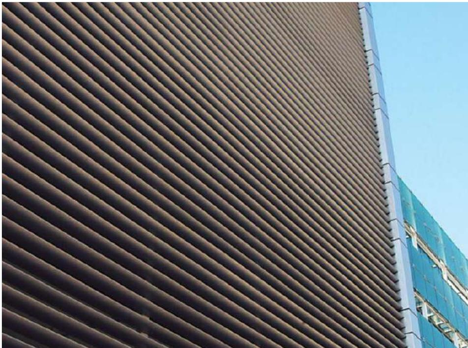
Figura 62. Exemplo de brise horizontal fixo utilizado nas fachadas norte e sul. Fonte: Sun Fix
