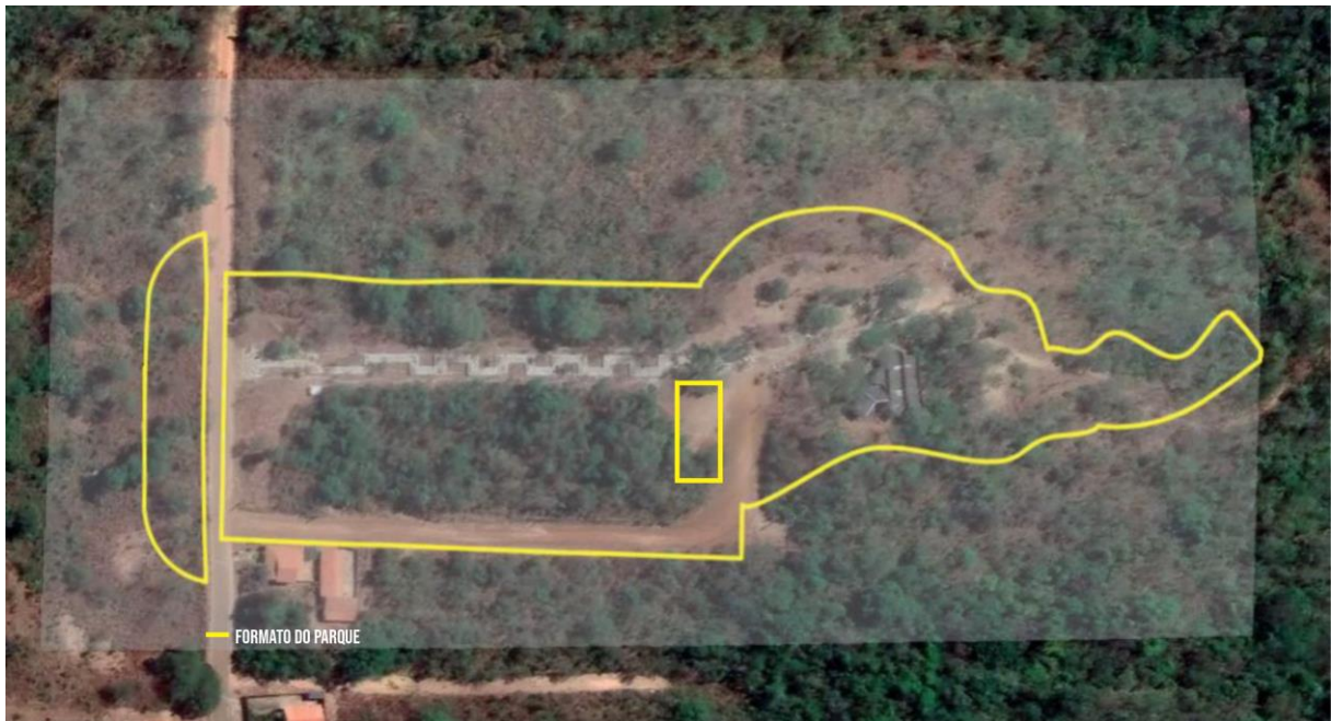
Figura 74 – Imagem aérea do terreno
