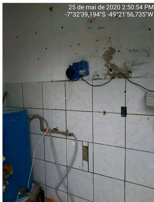
Figura 20: Bomba dosadora automática.
