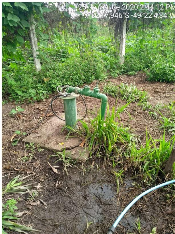
Figura 14: Poço Tubular Profundo n° 1.
