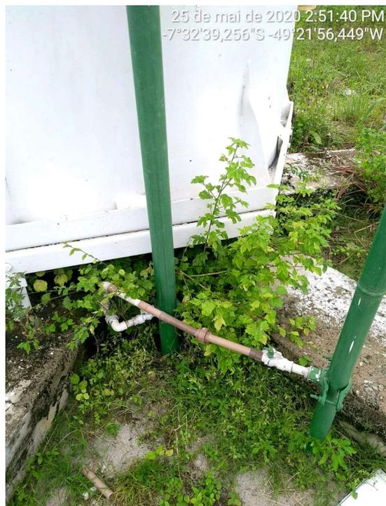
Figura 19: Entrada do cloro no Reservatório elevado.
