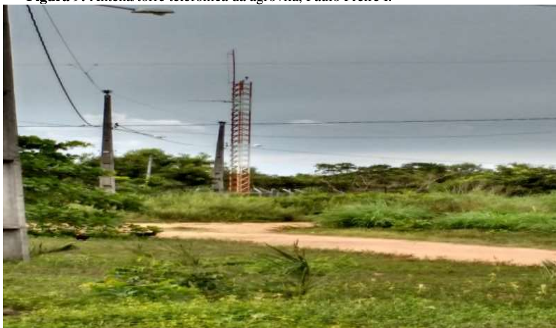
Figura 9: Antena/torre telefônica da agrovila, Paulo Freire I.
