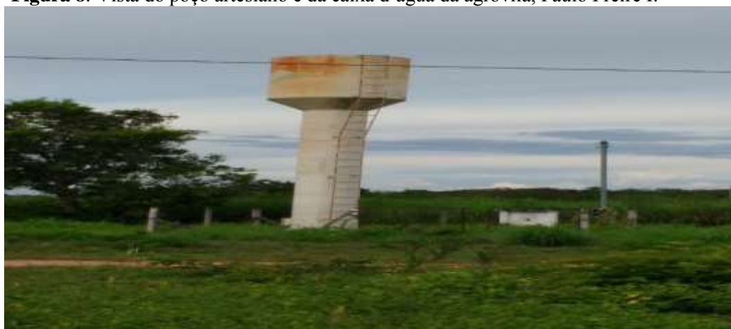
Figura 8: Vista do poço artesiano e da caixa d' água da agrovila, Paulo Freire I.
