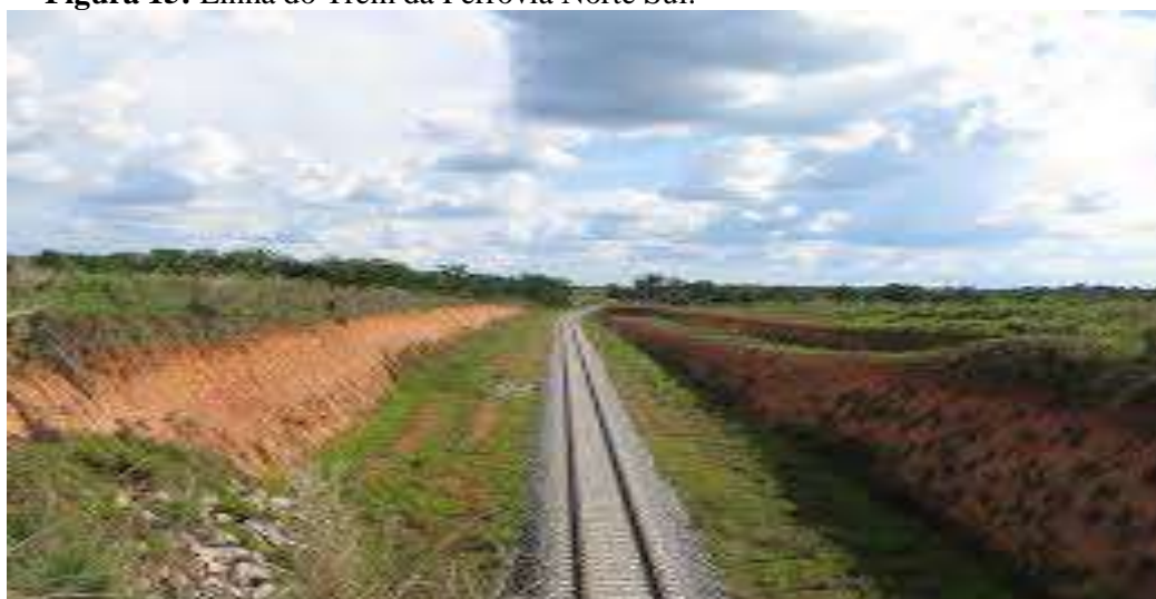
Figura 15: Linha do Trem da Ferrovia Norte Sul.
