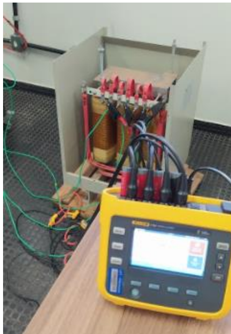
Figura 18 - Ligação entre o Analisador e o Autotransformador
