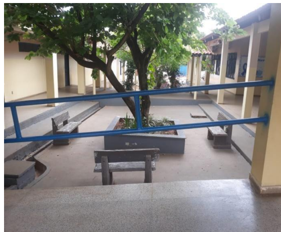
Figura 52 - Rampa de acesso, barras de mobilidade, área de ligação de pavilhão da Escola Estadual em Campos Lindos
