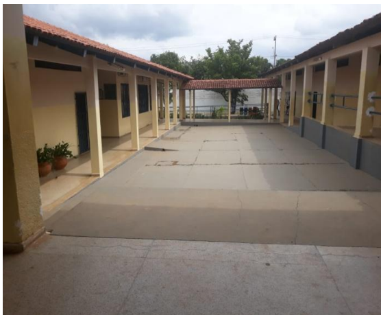
Figura 54 - Rampa de acesso e área de ligação de pavilhão da Escola Estadual em Campos Lindos
