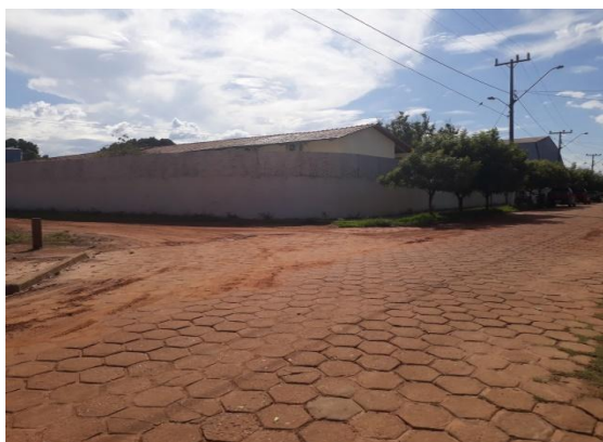
Figura 41 - Vista da entrada principal do prédio da Escola Estadual de Campos Lindos
