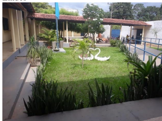
Figura 42 - Vista interna da entrada do portão principal da Escola Estadual de Campos Lindos
