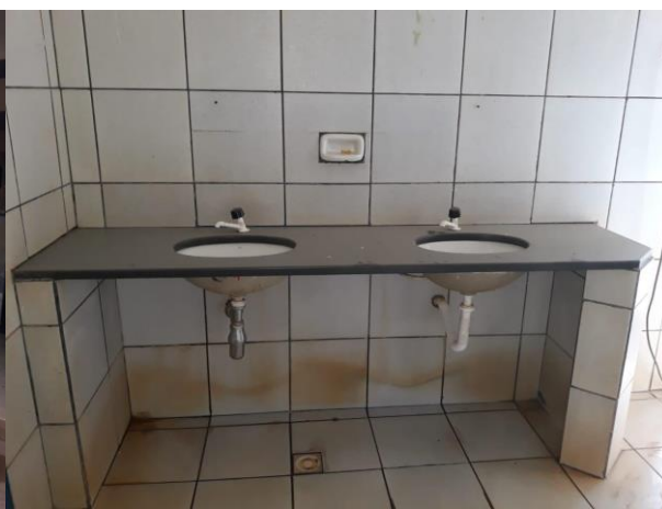
Figura 50 - Infiltrações nas paredes dos banheiros de alunos da Escola Estadual em Campos Lindos
