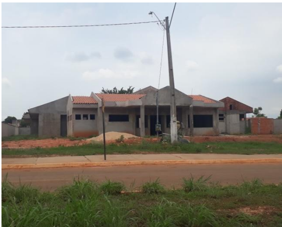
Figura 15 - Fachada da construção inacabada da creche do Proinfância em Campos Lindos
