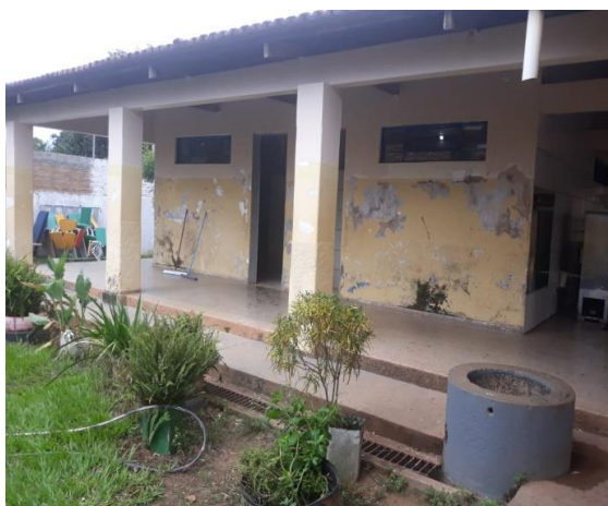
Figura 49 - Situação da parede dos banheiros de alunos da Escola Estadual em Campos Lindos
