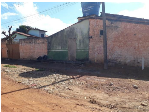
Figura 37 - Fachada lateral do prédio que recebe os alunos de 1º e 2º anos do ensino fundamental da rede municipal de Campos Lindos
