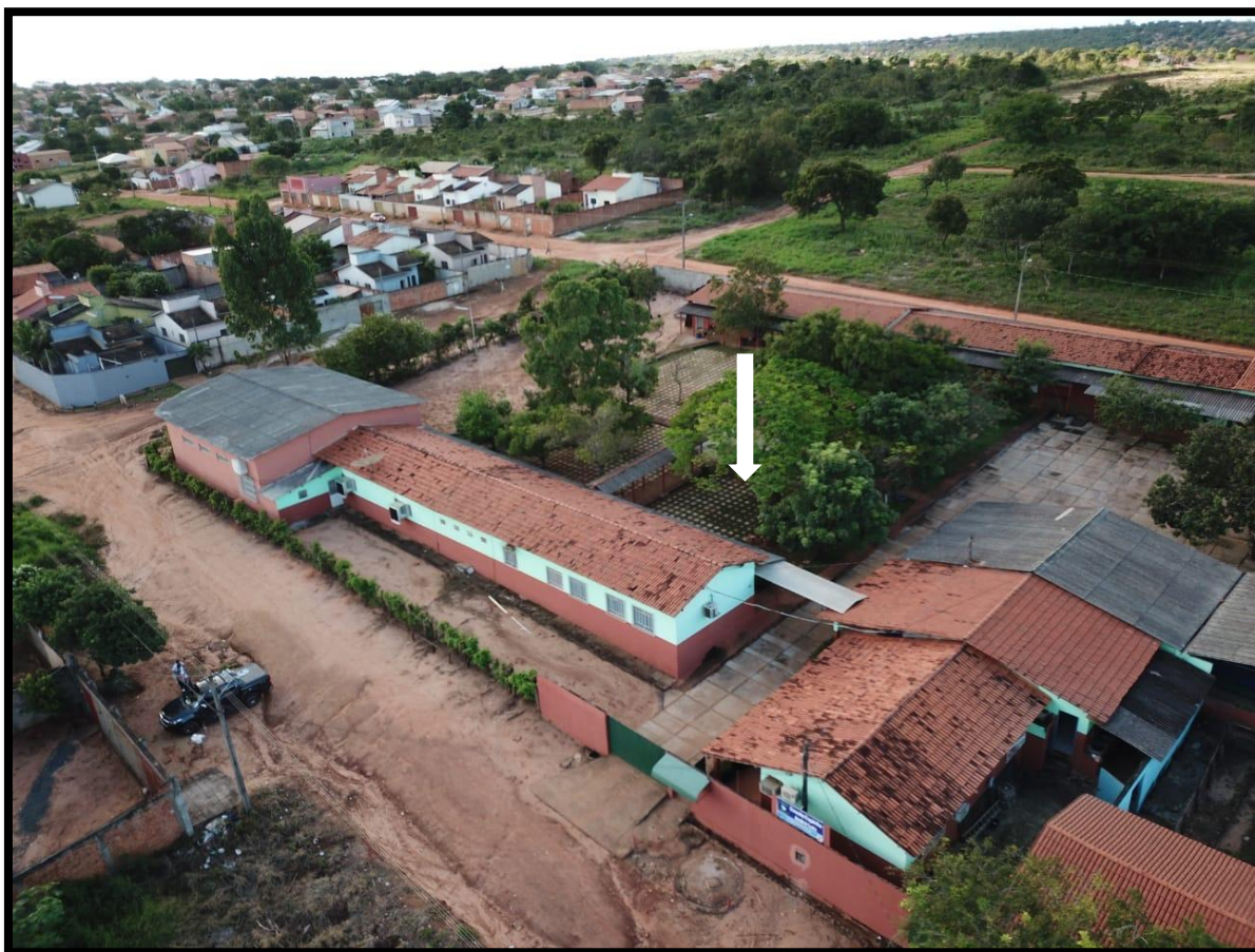
Fotografia 1 - Imagem aérea do bairro morada do sol 2 onde está localizada a escola Emanuel, em Araguaína.
