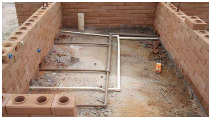
Figura 16: Alvenaria estrutural com tijolos de solo cimento.
