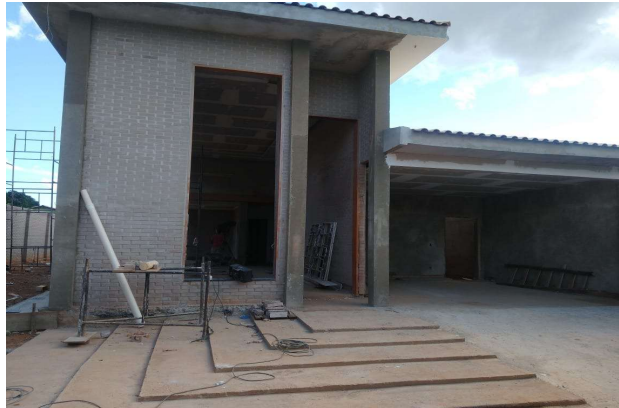
Figura 17: Alvenaria de vedação com tijolos de solo cimento.
