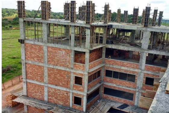
Figura 15: Alvenaria de vedação em estruturas de concreto armado.
