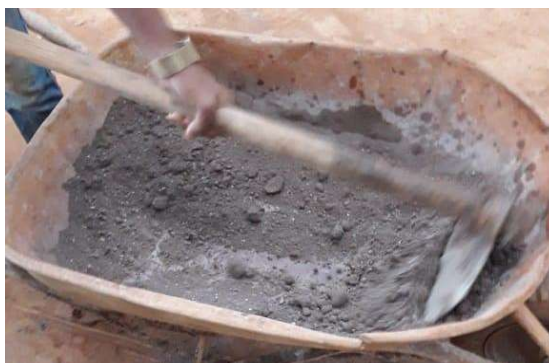
Figura 36: Homogeneização do solo para a moldagem dos tijolos.
