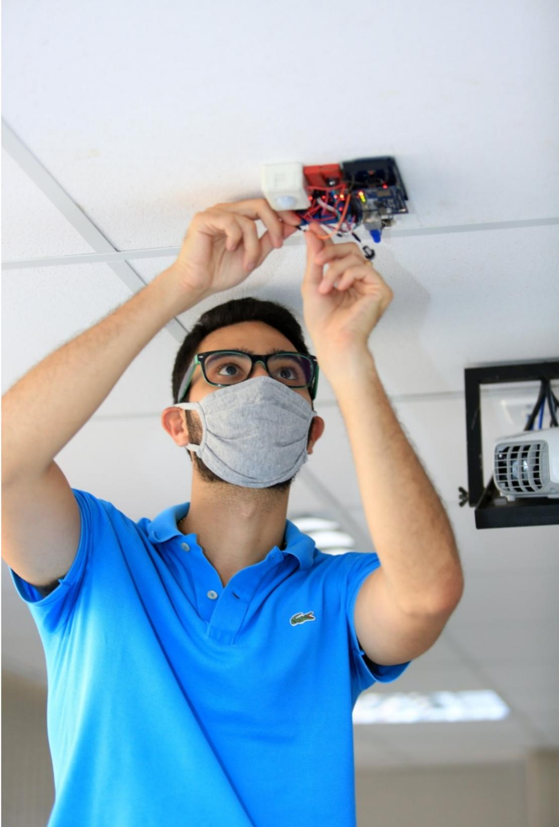
Finalizando com fechamento da caixa de proteção acrílica e vazada para refrigeração do microcontrolador.
