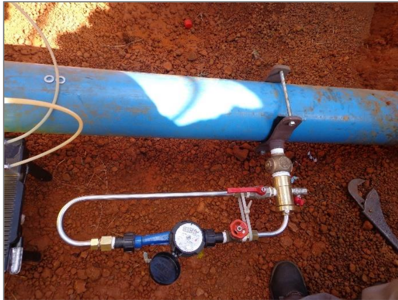
Figura 27: Foto do medidor proporcional instalado na tubulação. (Fonte: O autor, 2016)
