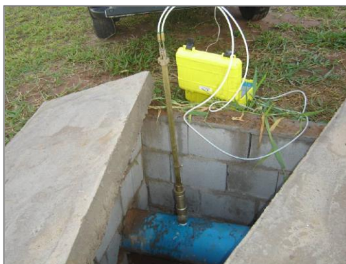
Figura 34: Maleta de Parâmetros Hidráulicos e tubo Pitot tipo Cole instalados. (Fonte: O Autor)
