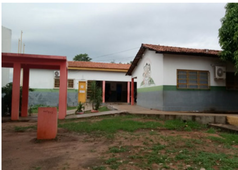
Figura 01 – Área interna da escola.
