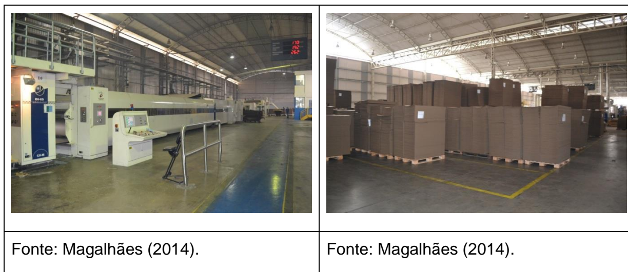
Figura 112 - Secadora e pátio de armazenamento de chapas.
