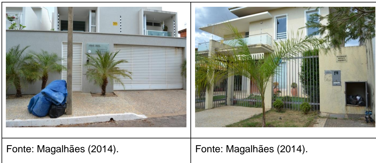
Figura 36 - Padrão visual das residências da quadra 404 Sul.
