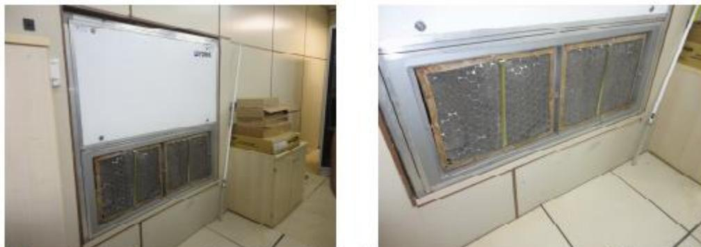
**Figura 9 - Condicionadores de ar sem limpeza periódica no ambiente de trabalho**
