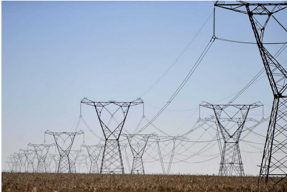
Figura 2 - Linhas de transmissão de energia elétrica
