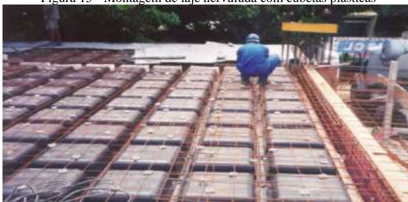
Figura 15 - Montagem de laje nervurada com cubetas plásticas
