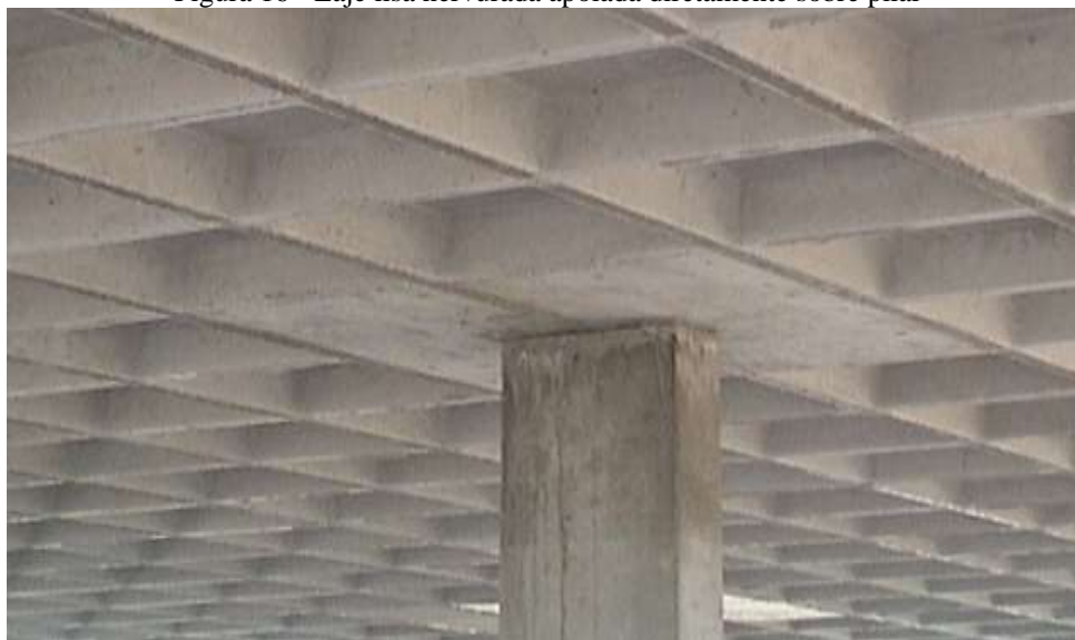
Figura 16 - Laje lisa nervurada apoiada diretamente sobre pilar
