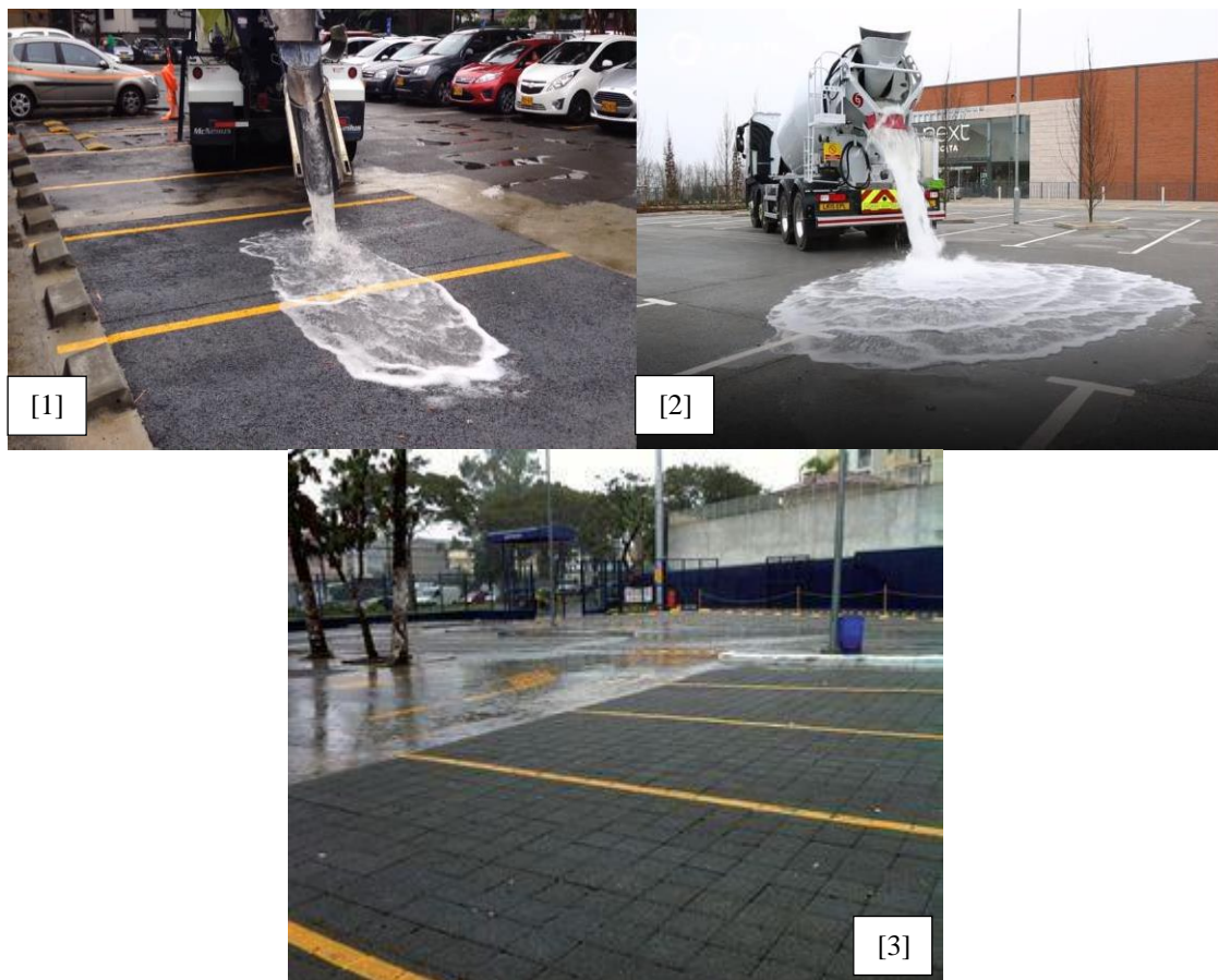
Figura 4 – (1) Pavimento poroso em asfalto; (2) Pavimento poroso em concreto; (3) Pavimento permeável em blocos pré-moldados de concreto.
