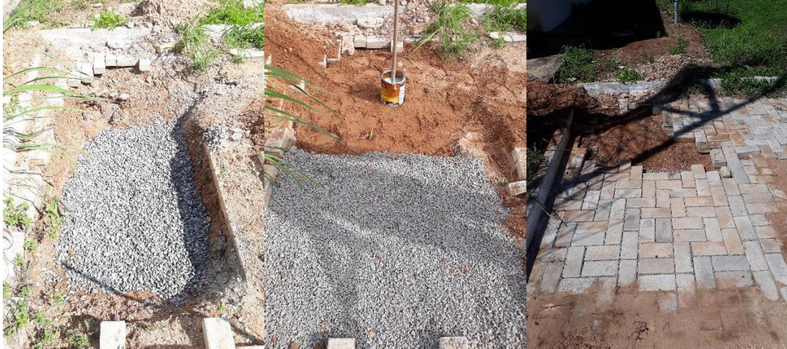
Figura 13 – Reconstrução do pavimento em blocos de concreto.
