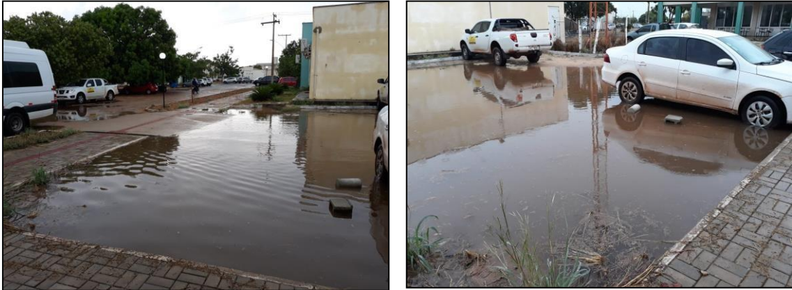
Figura 8 - Estacionamento do Restaurante Universitário - UFT.
