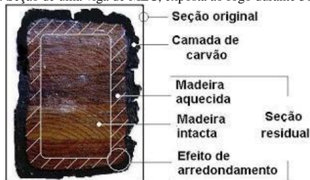
Figura 3: Seção de uma viga de MLC, exposta ao fogo durante 30 minutos
