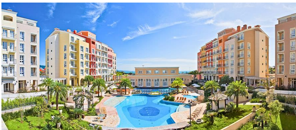
Figura 19: IL Campanário Vilaggio Resort
