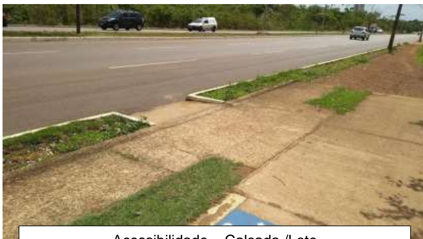
Acessibilidade – Calçada /Lote
