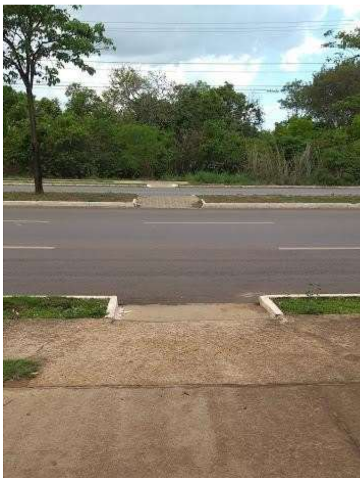
Acessibilidade – Calçada /Avenida LO - 05
