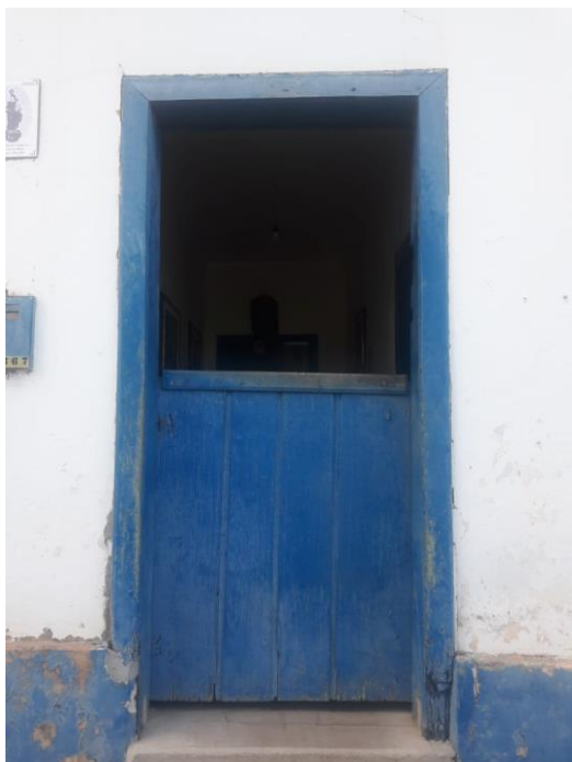
Figura 57- Porta e janela da fachada principal.
