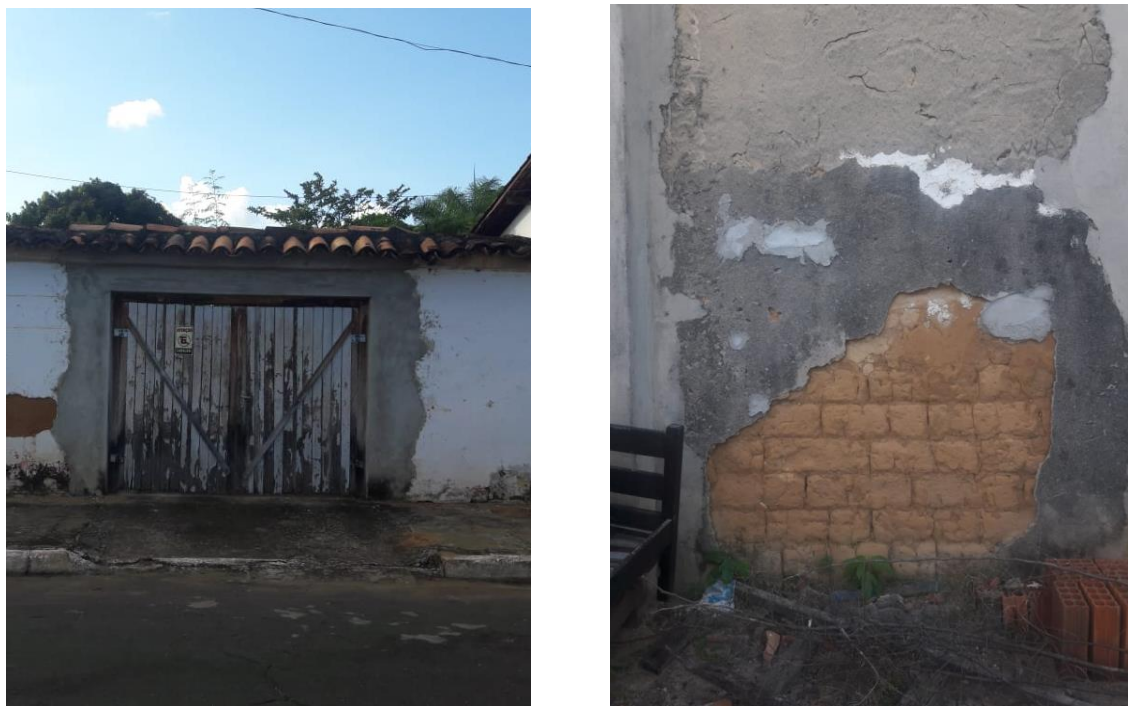
Figura 59 - Portão da garagem e parede original de adobe.
