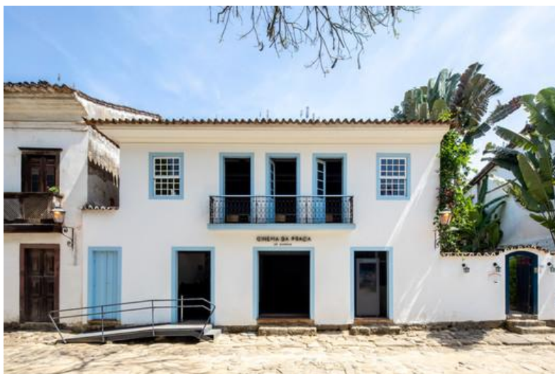
Figura 34 - Cinema da Praça, fachada.
