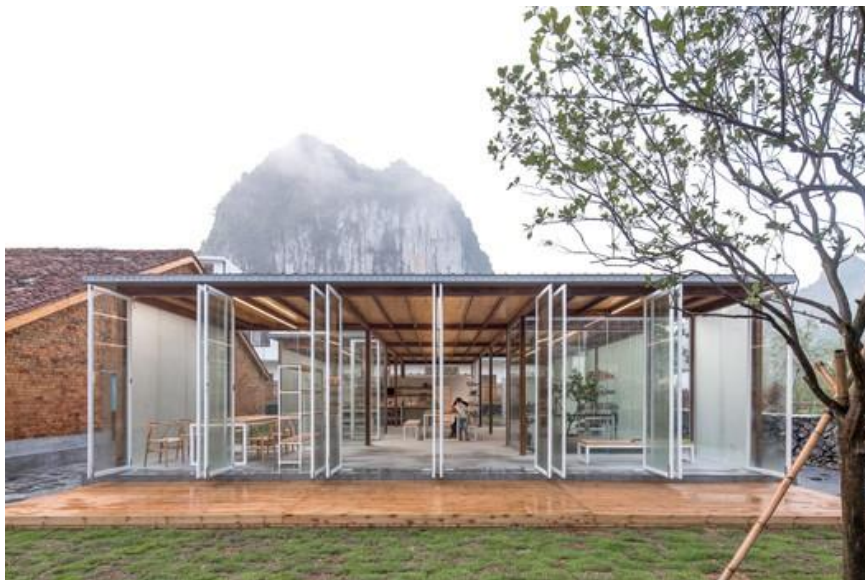
Figura 20 -Pátio Sul, fachada 01.
