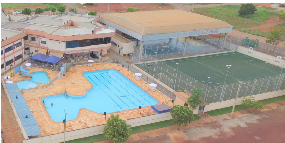
Figura 34 – Foto aérea das instalações esportivas
