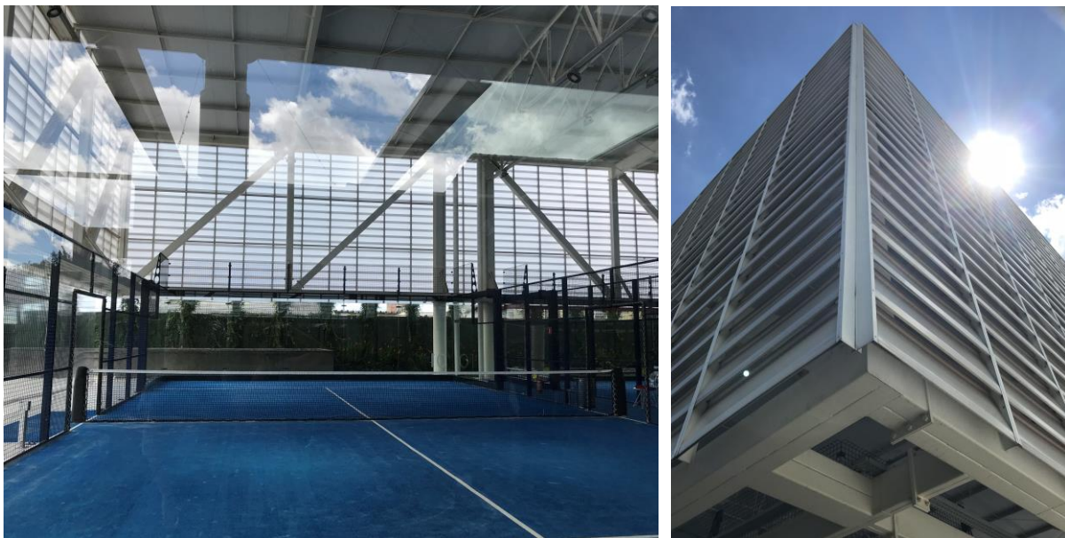
Figura 28 – Treliças; e Fachada com venezianas industriais de policarbonato
