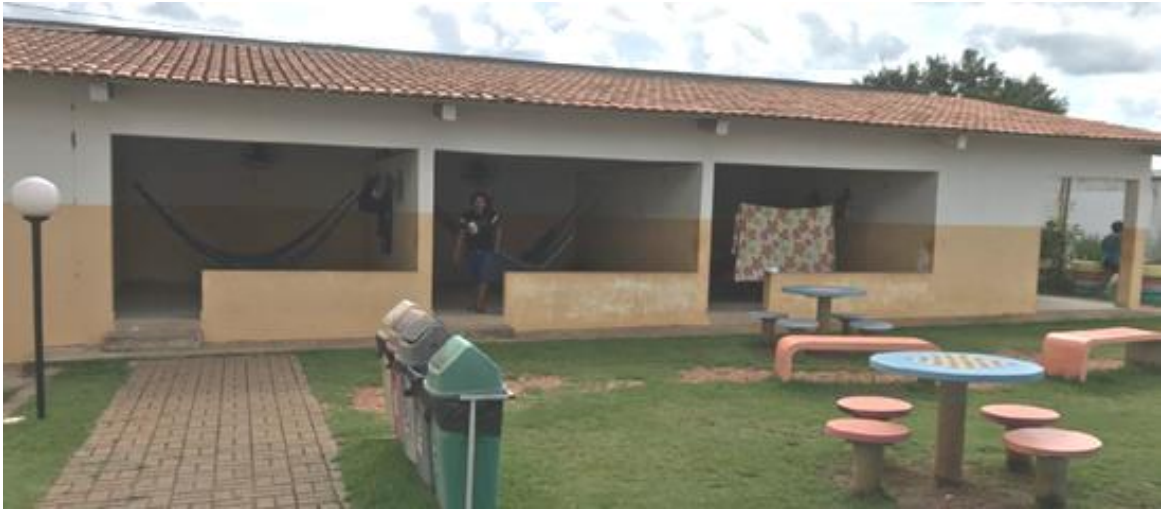
Figura 14 – Vista dos redários e área externa da CASAI Araguaína
