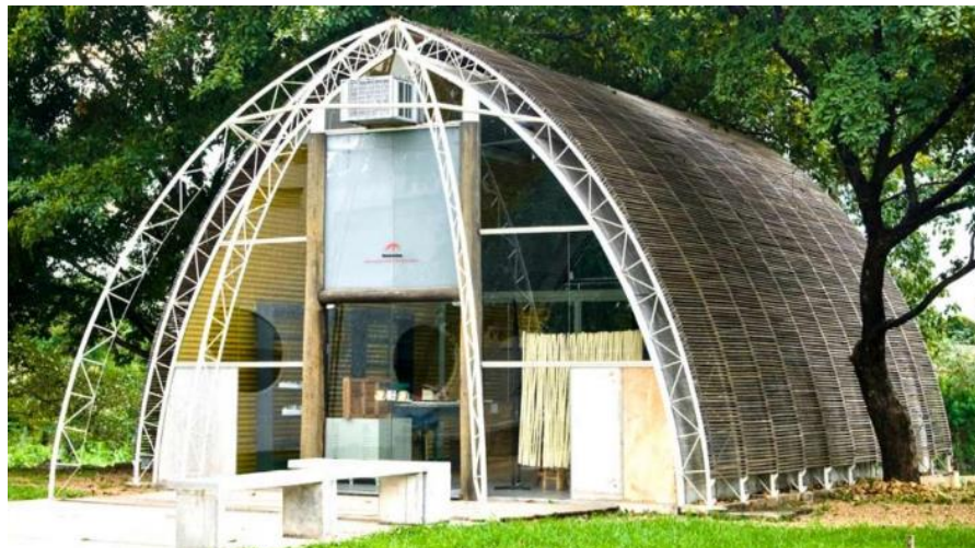
Figura 34 – Protótipo da CASAI do Projeto Tecnoíndia construído no câmpus da UFMT
