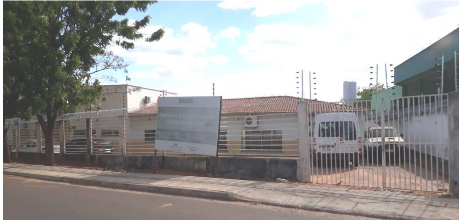
Figura 12 – Fachada principal da CASAI Araguaína
