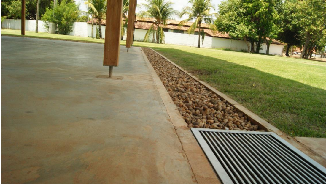
Figura 43 – Detalhes da estrutura e drenagem na Unidade Escolar de Canuanã
