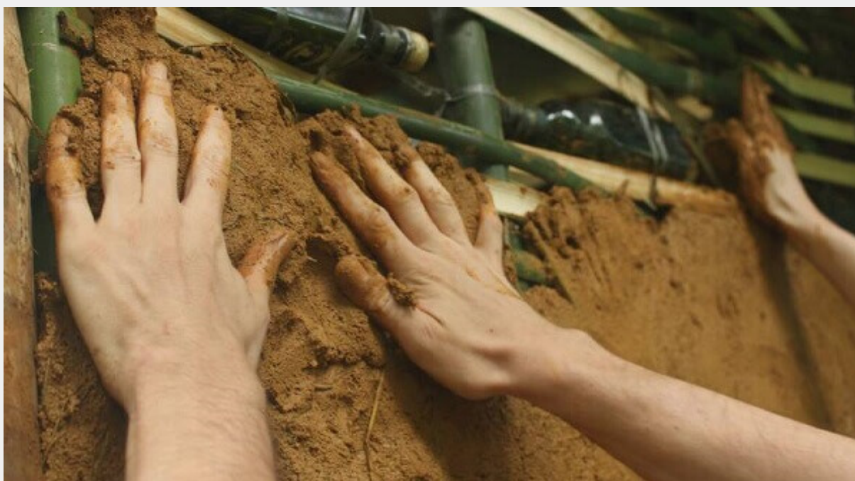
Figura 23: Construção de parede com técnica de Bambu-a-Pique e garrafas de vidro. Fonte: www.ciclovivo.com.br , 2017
