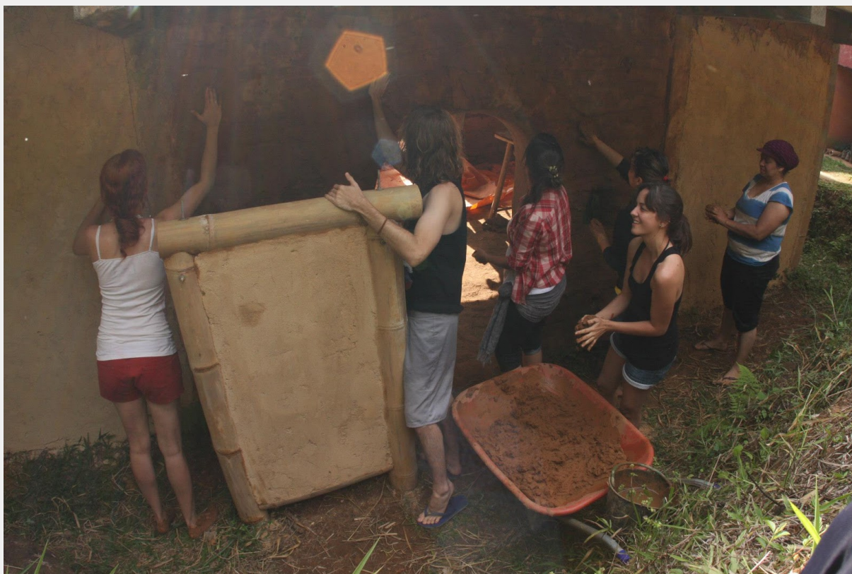
Figura 21: Grupo utiliza massa de adobe para rebocar uma parede de terra. Fonte: Autor, 2014
