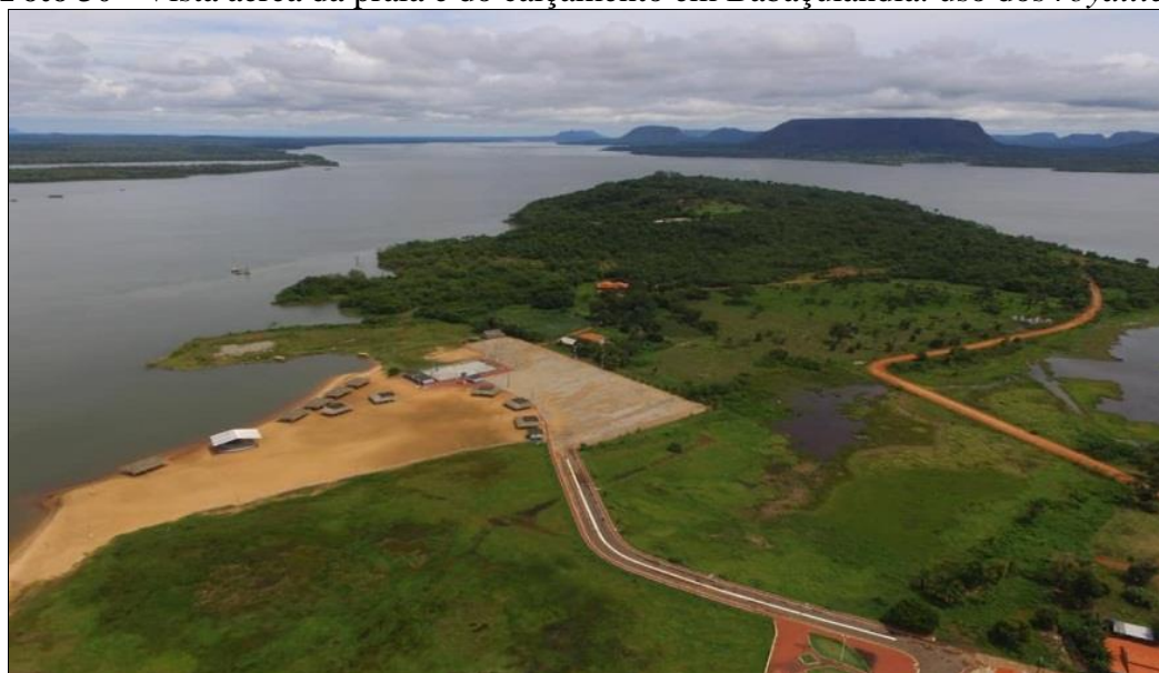
Foto 30 - Vista aérea da praia e do calçamento em Babaçulândia: uso dos royalties
