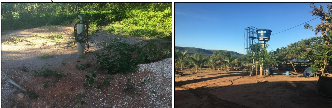
Foto 26 - Poço artesiano no Baixão e Foto 27 - Reservatório das residências no Baixão
