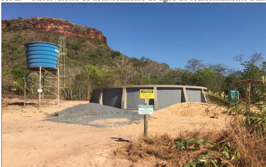
Foto 29 - Reservatório de abastecimento de água no reassentamento Baixão
