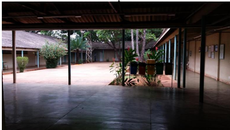
Imagem 3 – Blocos das salas de aula da Unidade Centro do Campus da UFT de Tocantinópolis-TO.
