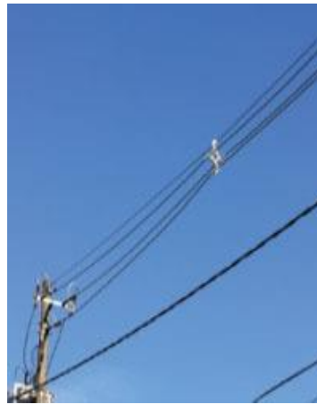
Figura 5 - Rede aérea compacta
