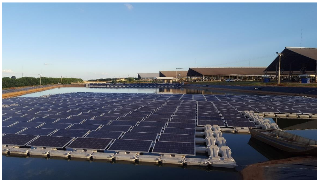
Figura 15- Usina Flutuante Fazenda Figueiredo (GO).
