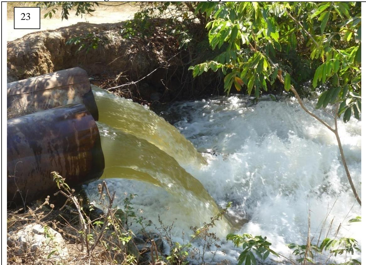
Foto 23: Bombeamento de água do rio Javaés para os canais de irrigação.
